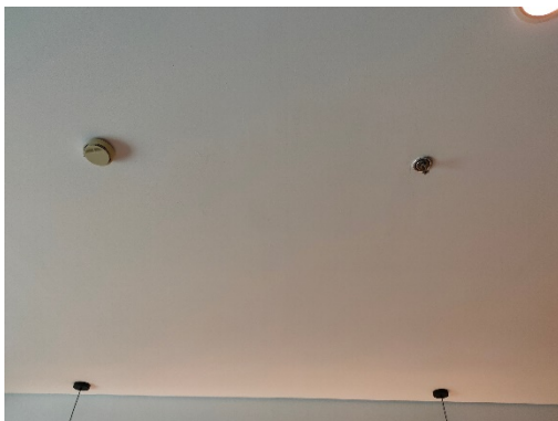
รูปที่ 3.2-15 ตัวอย่างการติดตั้งระบบป้องกันและเตือนอัคคีภัยภายในโครงการ
