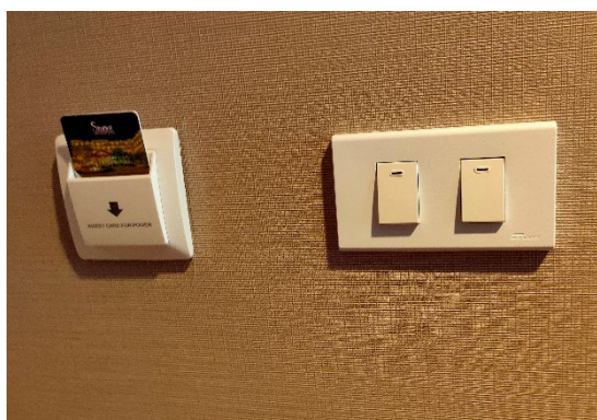
รูปที่ 3.2-27 ระบบ access control ด้วย ระบบ keycard และระบบ control การ ใช้พลังงานภายในห้องพัก
