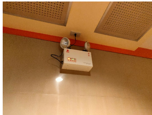
รูปที่ 3.2-14 การติดตั้งไฟฟ้าสำรองภายในโครงการ
