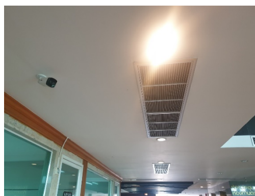
รูปที่ 3.2-28 ตัวอย่างการติดตั้งกล้องวงจรปิด CCTV ภายในโครงการ
